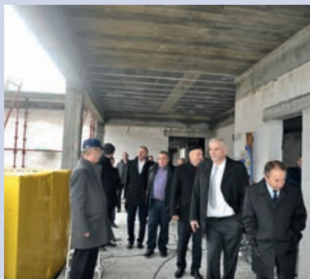
Na placu budowy sali gimnastycznej przy SP w Białobielu
