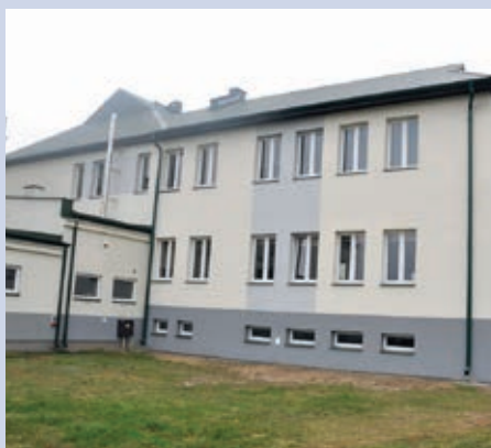
Budynek ZS w Obierwi po termomodernizacji
