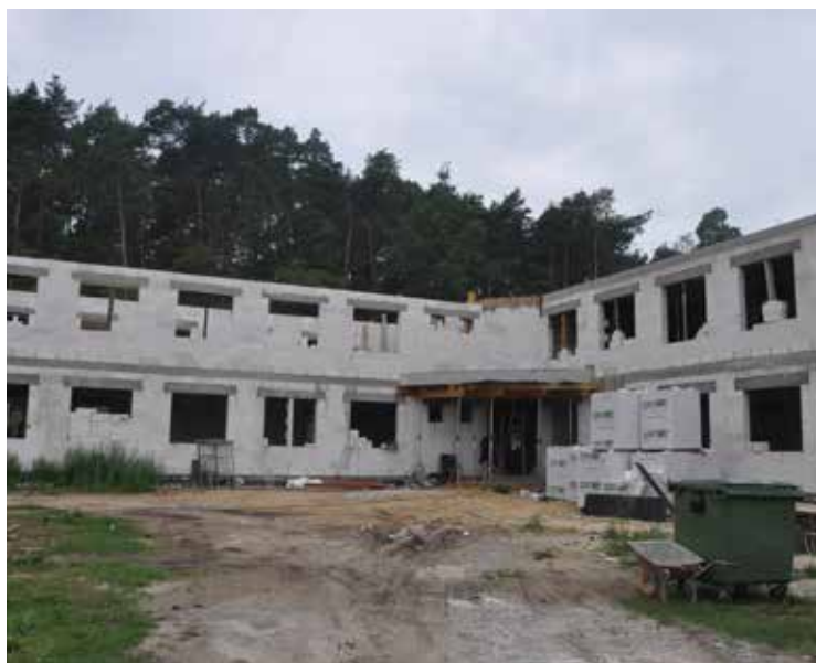
Budowa nowego Urzędu Gminy
