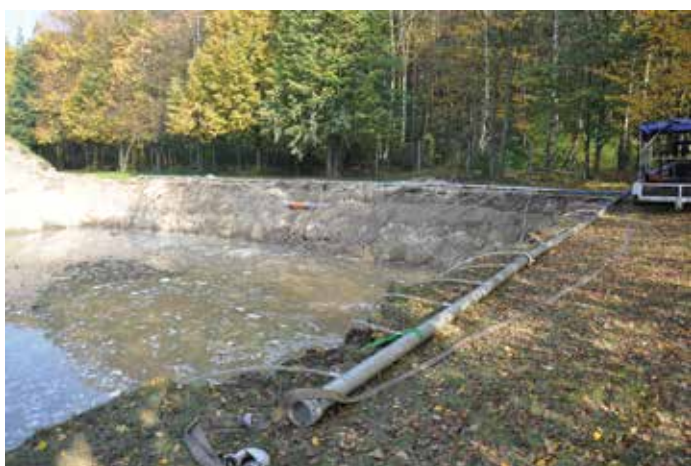
Rozbudowa i modernizacja oczyszczalni ścieków w Lelisie
