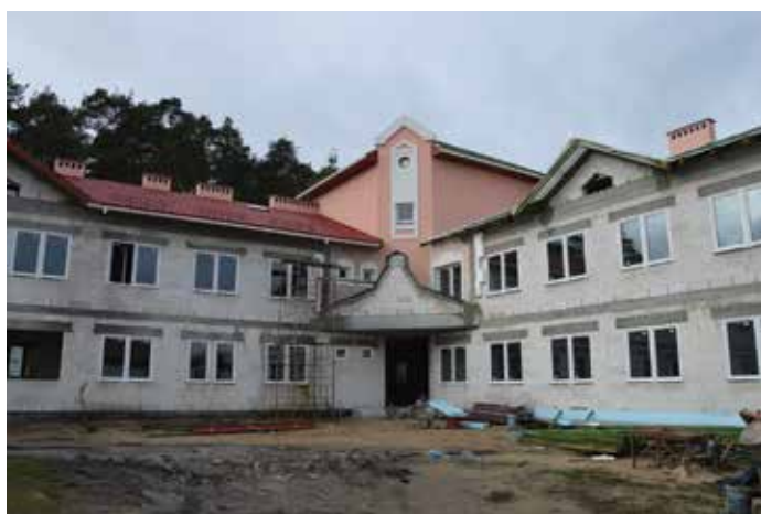
Budowa nowego Urzędu Gminy
