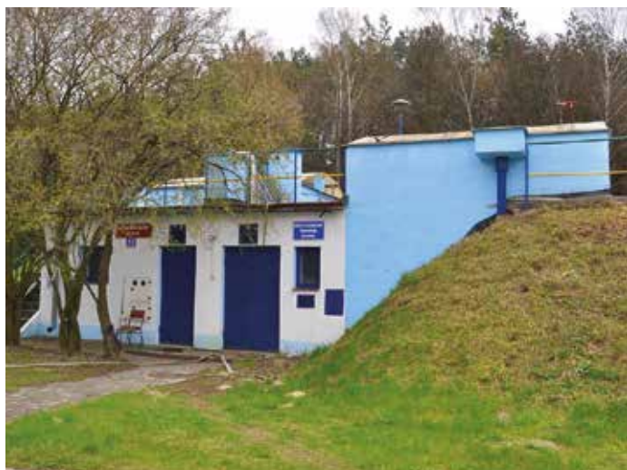
Rozbudowa oczyszczalni ścieków w Leliszach wraz z budową kanalizacji sanitarnej ciśnieniowej w Leliszach i Durlasach – stan przed rozpoczęciem prac.
