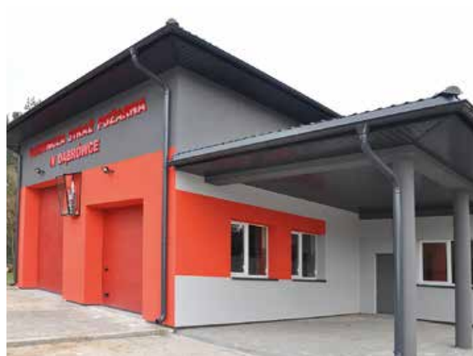
Remont remizy OSP w Dąbrowce – stan po odbiorze i zakończeniu prac.
